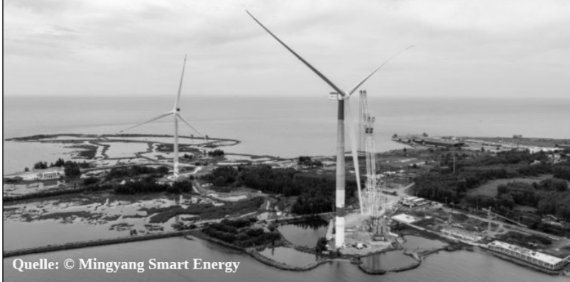
Abb. 2: Das (2024) leistungsstärkste Windrad der Welt – 20 MW/ 80 GWh – China, Provinz Hainan
